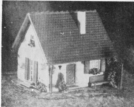
Fig. 4. L'opération n'est pas encore terminée mais déjà on peut voir les plaques effritées sur les murs.
